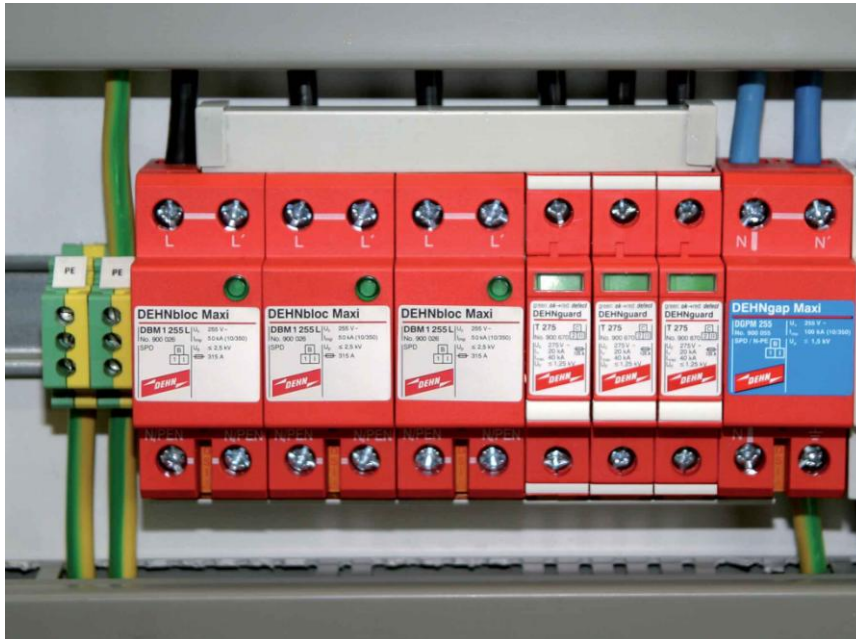
Rys. 6. Połączenie układu ograniczników DEHNBloc Maxi 1 255 L (SPD typ 1) z ogranicznikami typu 2 bez dodatkowych elementów
