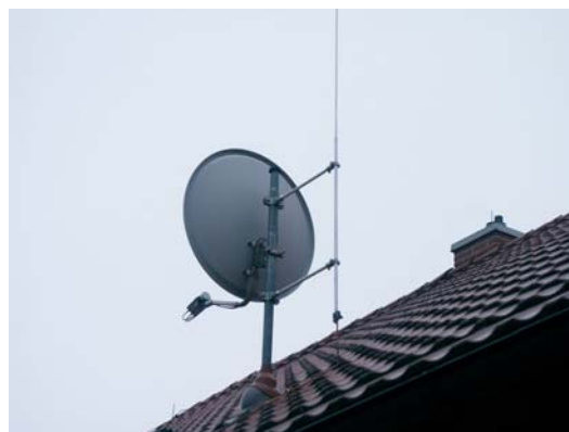
Rys. 9. Ochrona masztu i anteny przed bezpośrednim oddziaływaniem prądu piorunowego [14]
