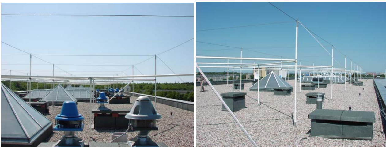
Rys.6. Ochrona odgromowa urządzeń na dachu obiektu budowlanego
