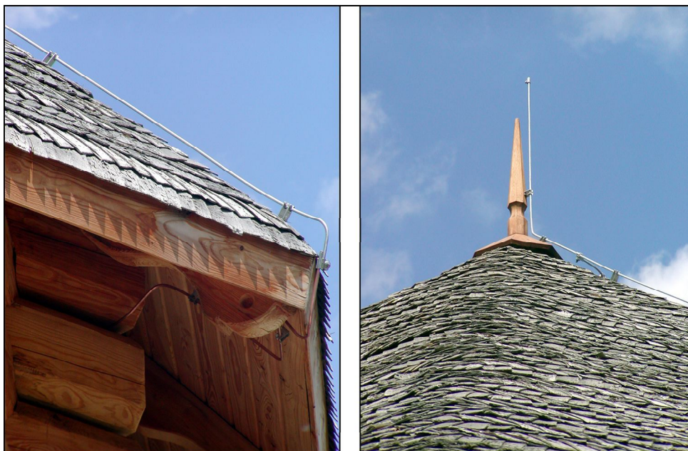
Zdjęcie 12. Instalacja odgromowa na modnym ostatnio pokryciu wiórem osikowym.
