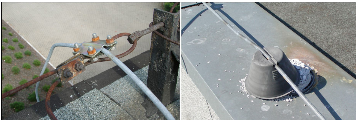
Zdjęcie 10. Kiepska jakość materiałów użytych do budowy instalacji odgromowych, to więcej pracy przy późniejszej konserwacji i krótszy okres eksploatacji.
