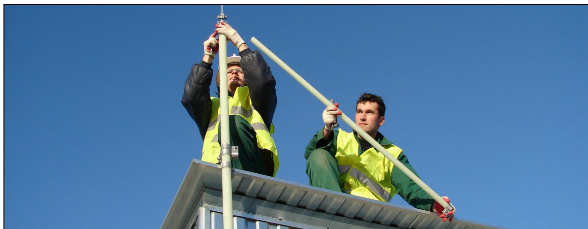
Zdjęcie 7. Montaż zwodów odsuniętych na centrali klimatyzacyjnej.
