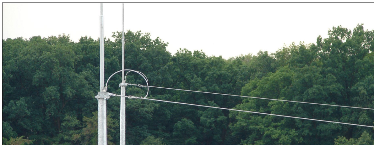
Zdjęcie 3. Zwody izolowane oparte na 22 metrowych masztach odgromowych chroniących zbiorniki spiryтусu.
