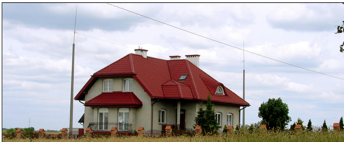
Zdjęcie 4. Typowy zwód izolowany w układzie dwuwymiarowym zastosowany do ochrony domu jednorodzinnego.
