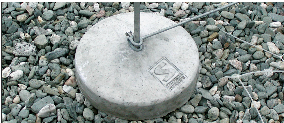
Zdjęcie 11. Elementy betonowe w instalacjach odgromowych powinny być mrozoodporne (spełniać wymogi norm PN-88/B-06250 i PN-EN 1338:2005), aby zapewnić długotrwałą ich eksploatację.
